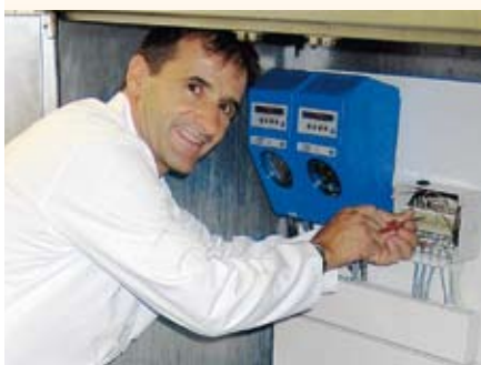
Horeca-Servicetechniker Martin Monn installiert eine Dosieranlage im Culinarium Restaurant Postino in Luzern.
